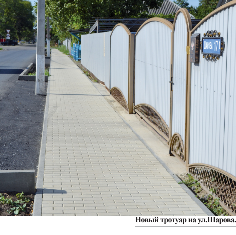
Новый тротуар на ул.Шарова.
