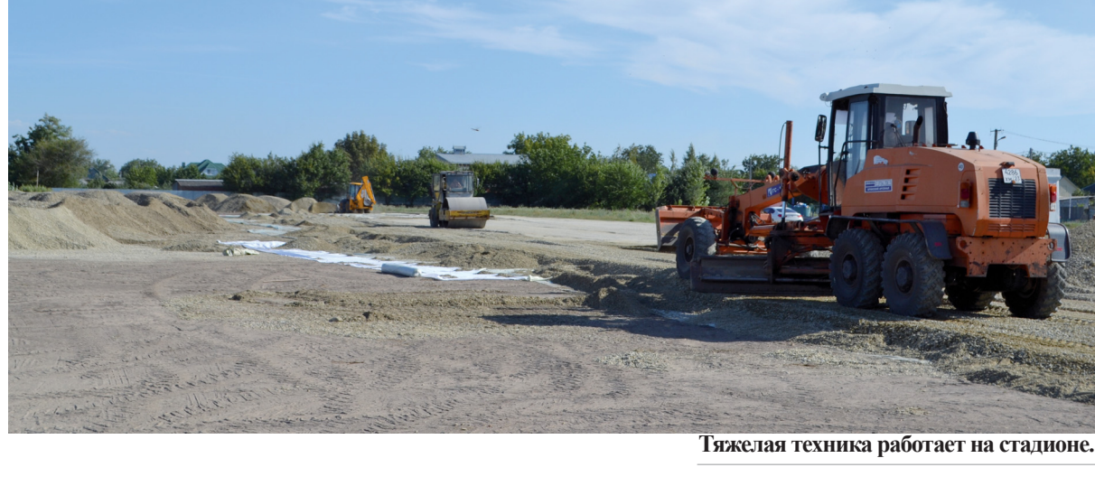
Тяжелая техника работает на стадионе.
