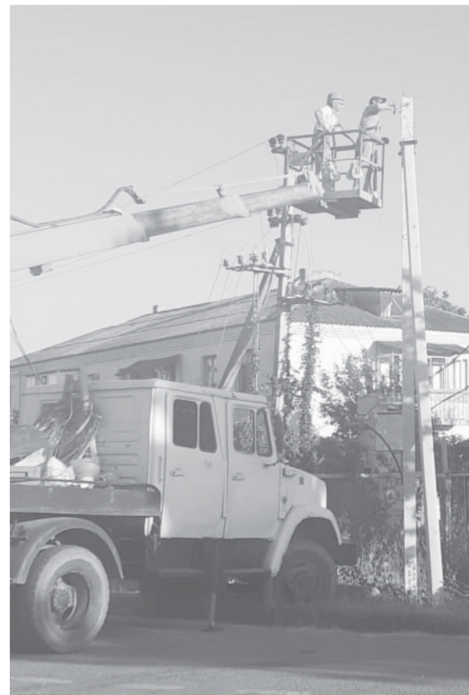
Капремонт линии электропередач.
