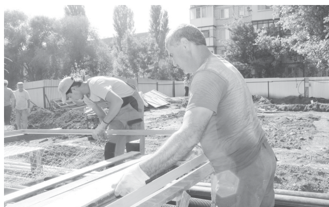
Подготовительные работы для установки нового блока котельной.
