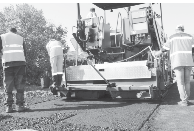
Асфальтирование одной из городских дорог.
