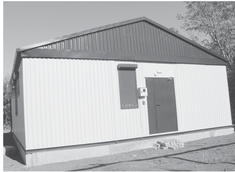
Вот он, строящийся ФАП в х. Новонекрасовском.
