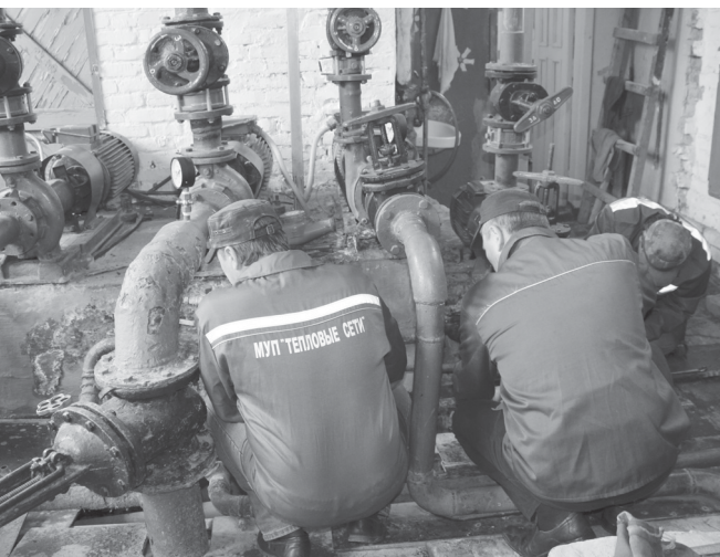
Профилактические работы в котельной.
