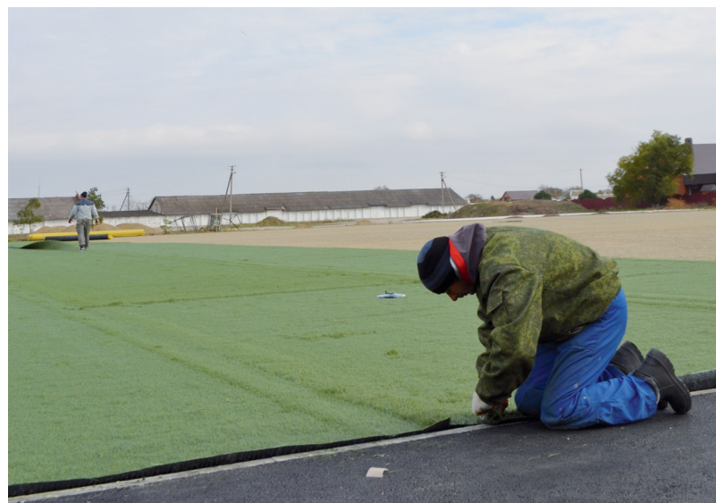
Рабочие укладывают искусственный газон на стадионе
