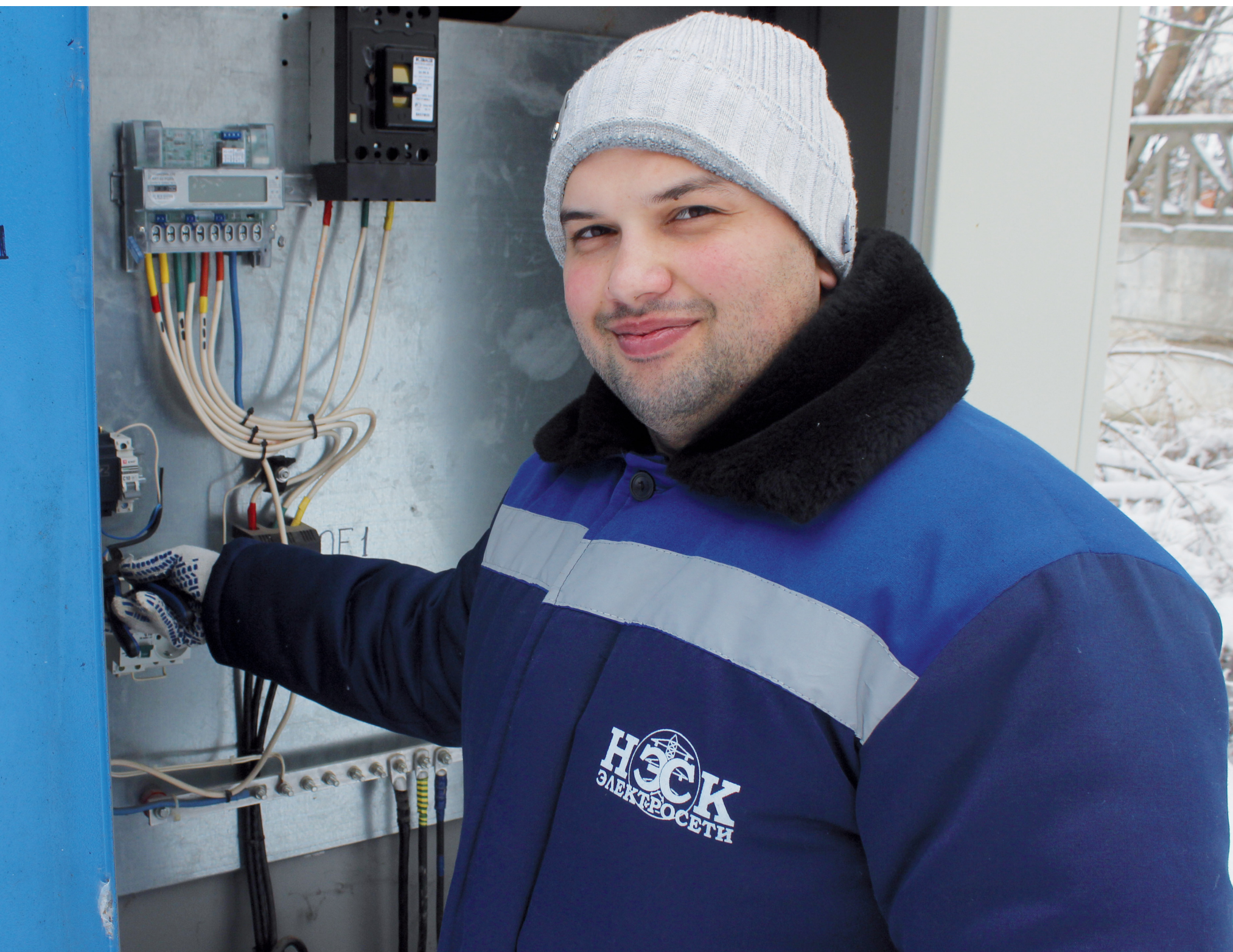
Электромонтер по эксплуатации приборов учета 4-го разряда Сергей Драчев за работой
